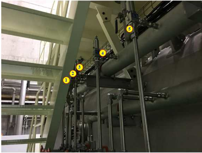
그림 14 DBU 안전밸브 설치 위치[헬륨설비실]
