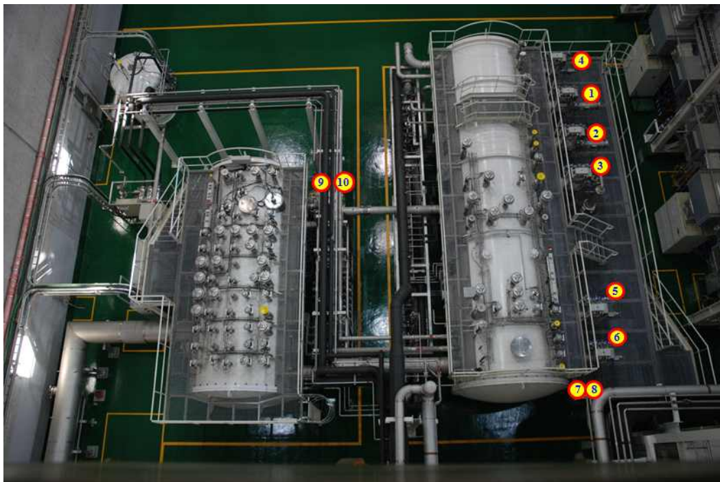
그림 8. 헬륨설비실에 대한 냉각수 라인의 안전밸브 설치 위치
