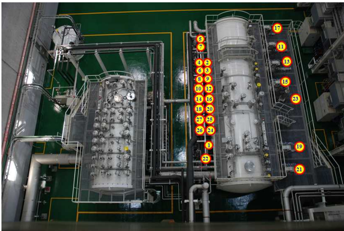
그림 3. 헬륨설비실에 대한 Cold Box의 안전밸브 설치 위치
