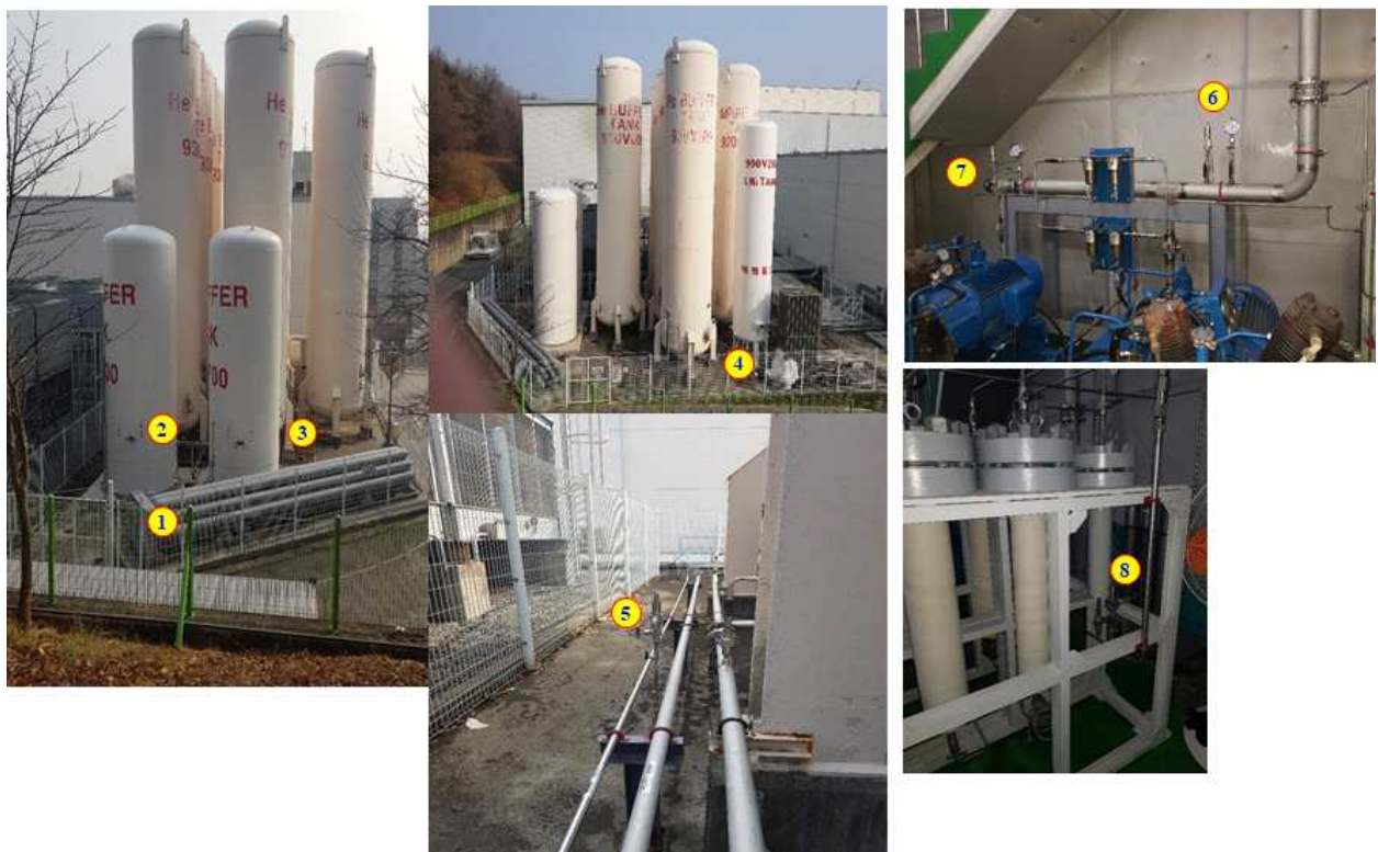
그림 12. 1kW recovery system 안전밸브 위치 사진
