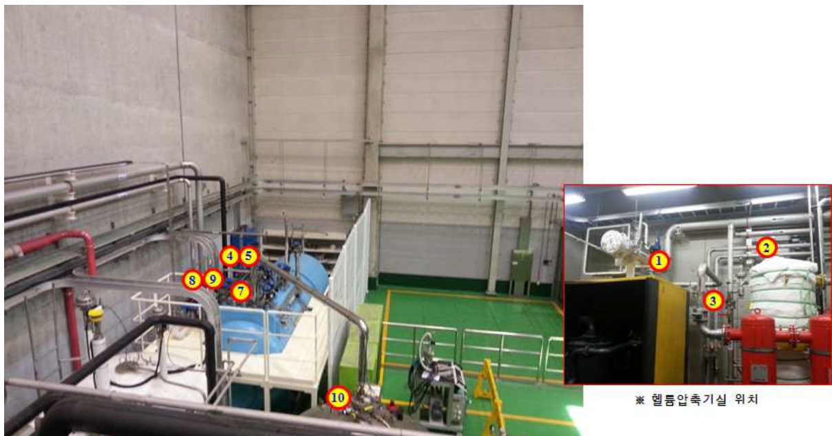
그림 11. 헬륨압축기실/헬륨설비실에 대한 1 kW 헬륨냉동기의 안전밸브 설치 위치
