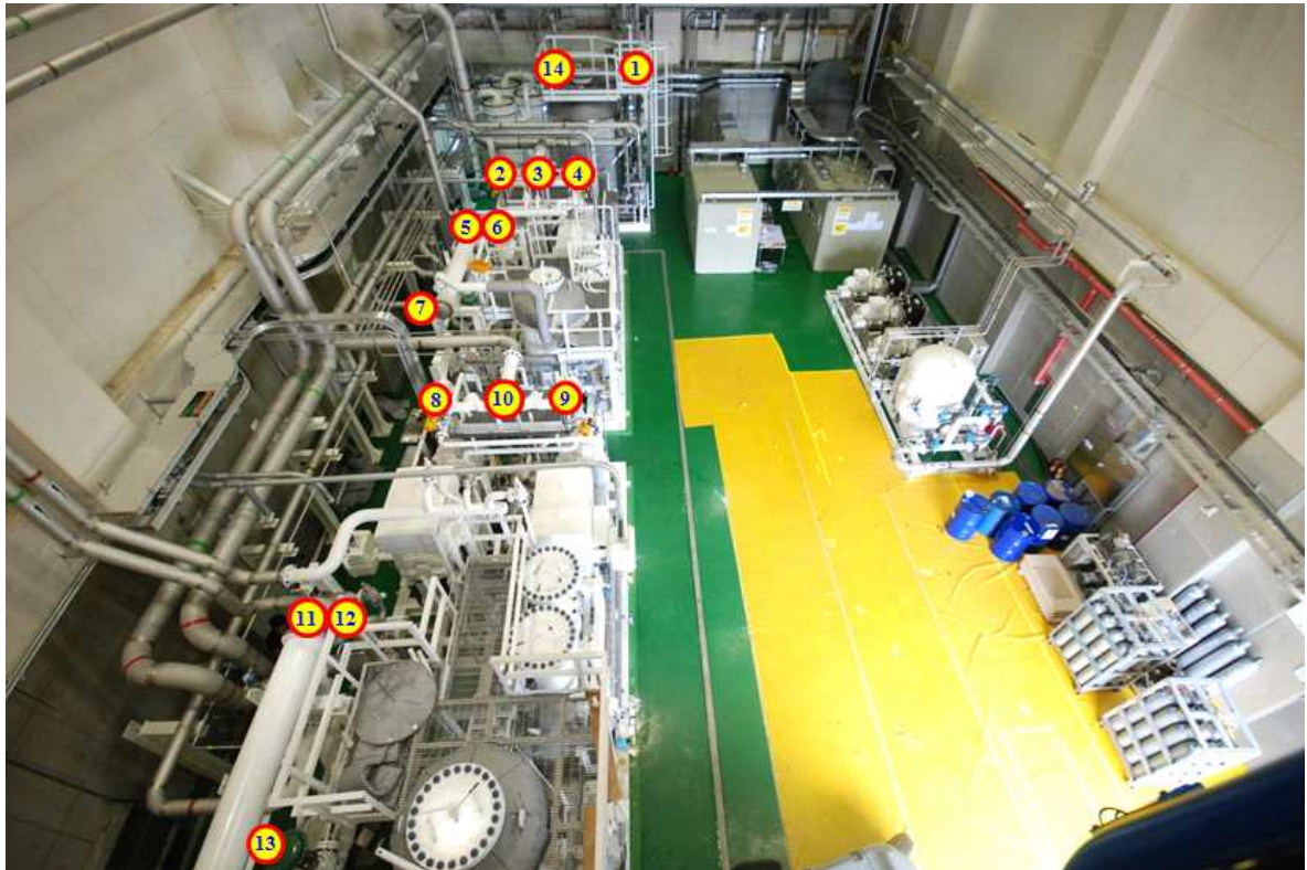
그림 2. 헬륨압축기실에 대한 헬륨압축기시스템의 안전밸브 설치 위치
