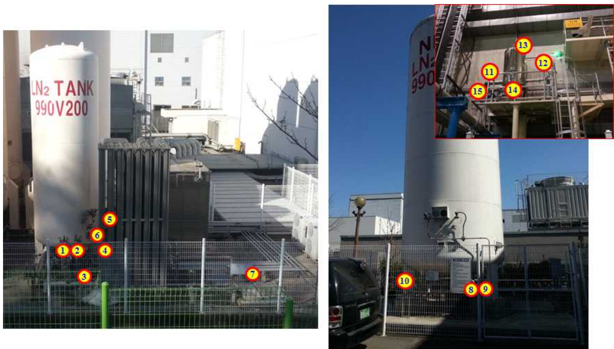
그림 10. 질소 저장실 대한 질소 저장소의 안전밸브 설치 위치
