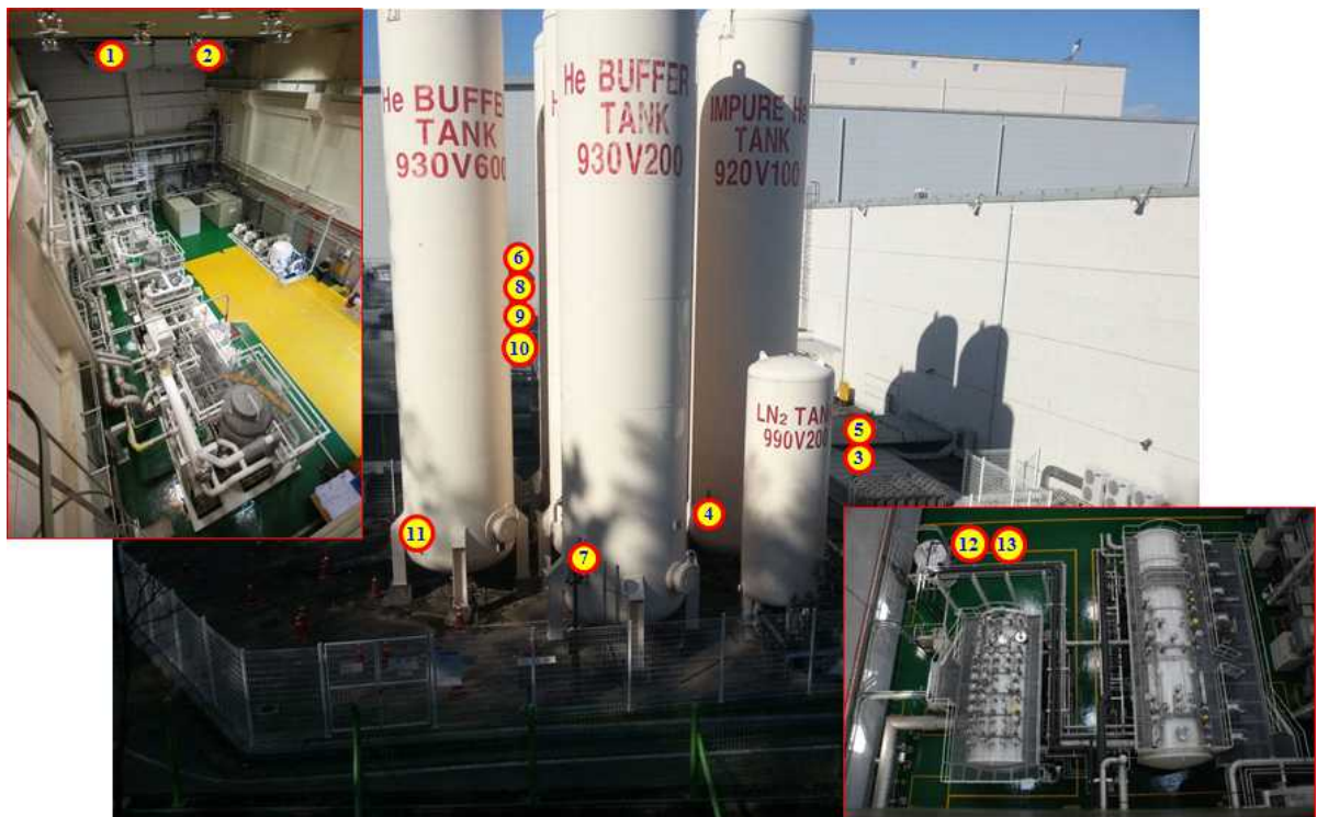
그림 9. 헬륨압축기실/설비실/저장실 대한 헬륨 저장소의 안전밸브 설치 위치
