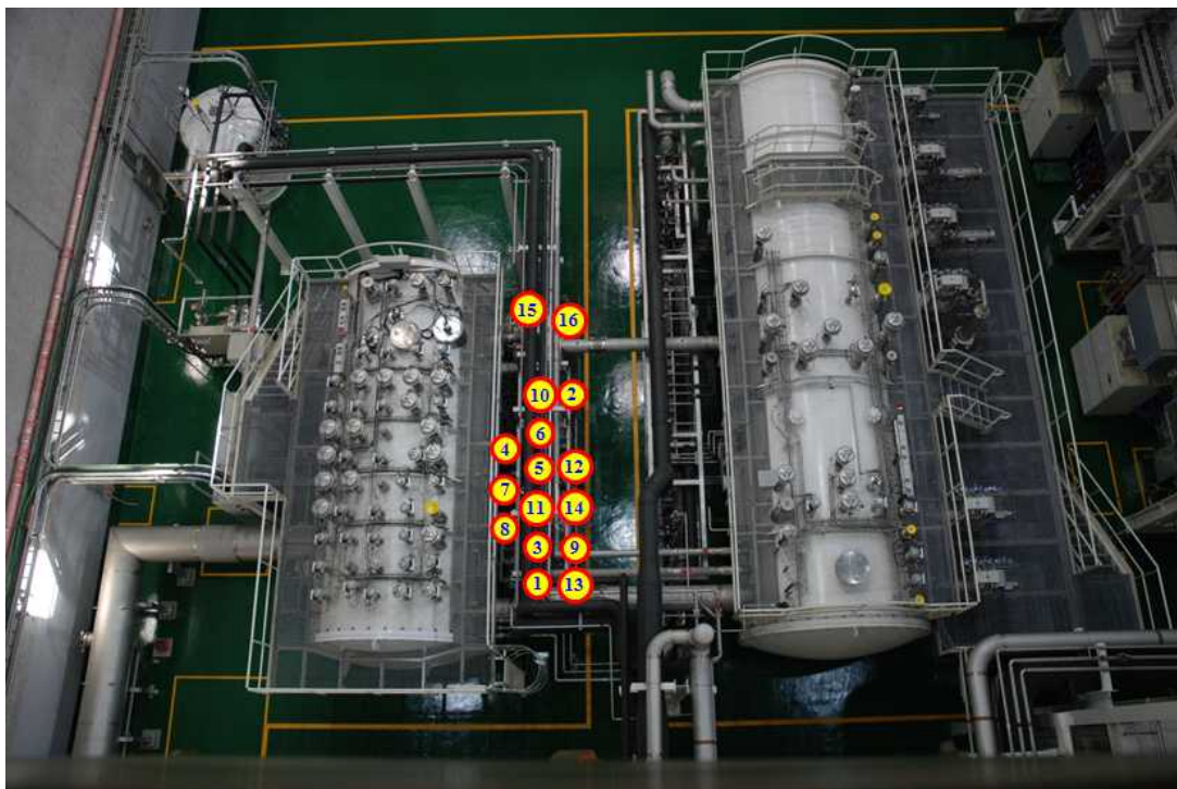
그림 4. 헬륨설비실에 대한 헬륨분배시스템의 안전밸브 설치 위치
