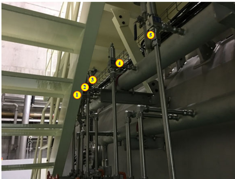
그림 14 DBU 안전밸브 설치 위치[헬륨설비실]
