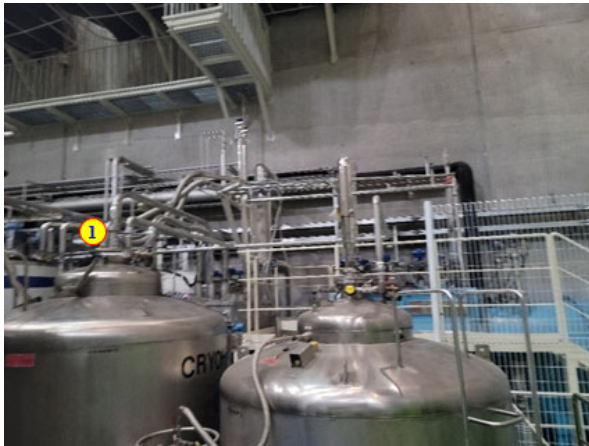
그림 16 CTB safety valve 위치
