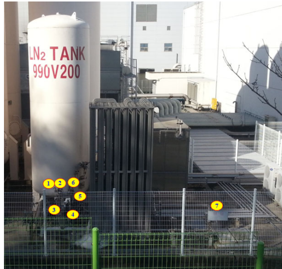
그림 11 9kW HRS 질소탱크 안전밸브 위치
