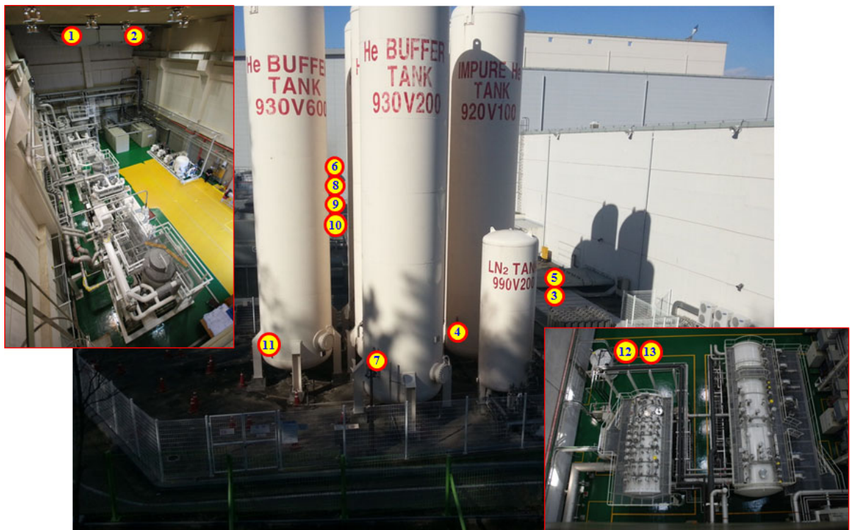
그림 9. 헬륨압축기실/설비실/저장실 대한 헬륨 저장소의 안전밸브 설치 위치
