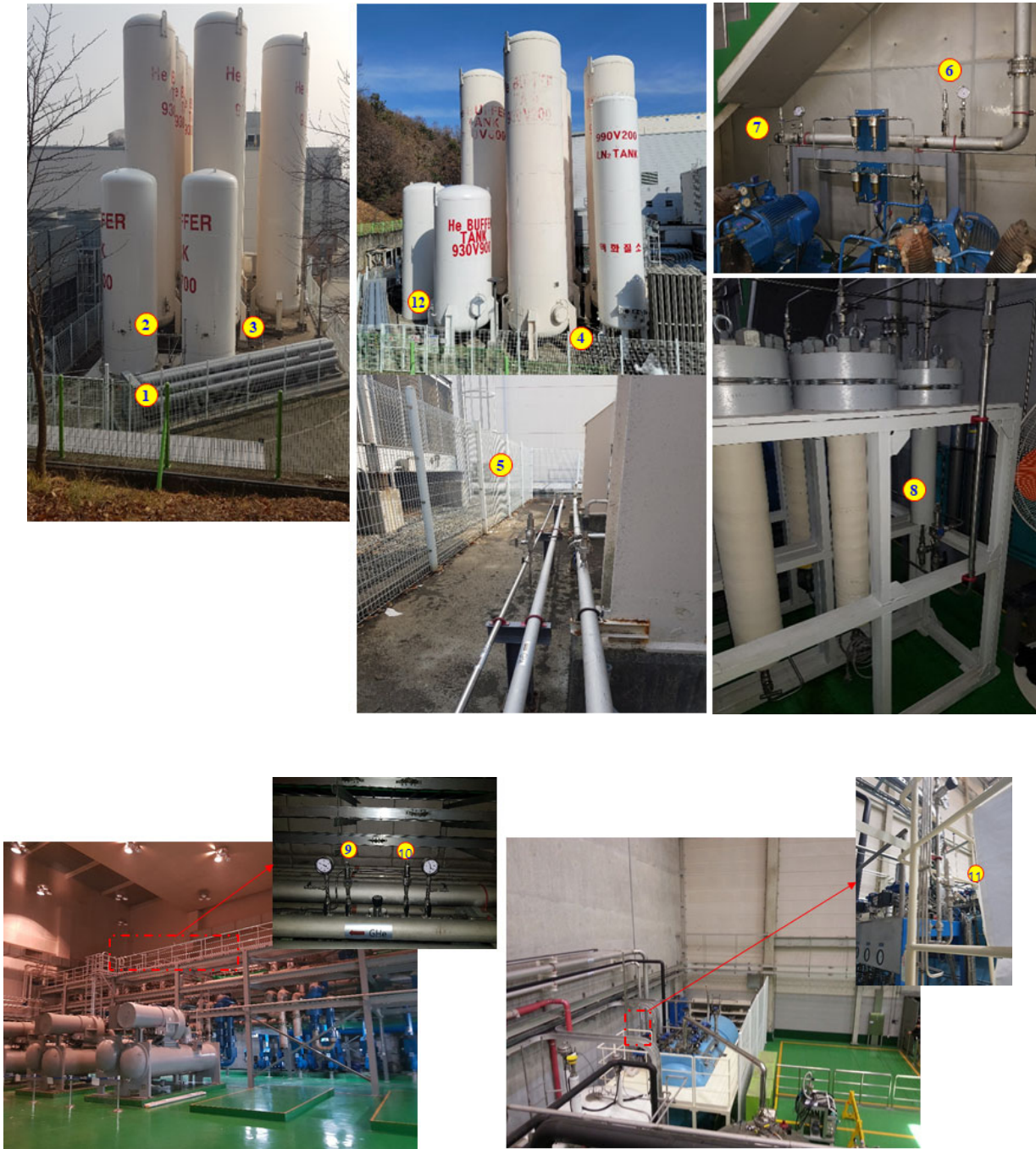
그림 15 1kW HRS 안전밸브 위치
