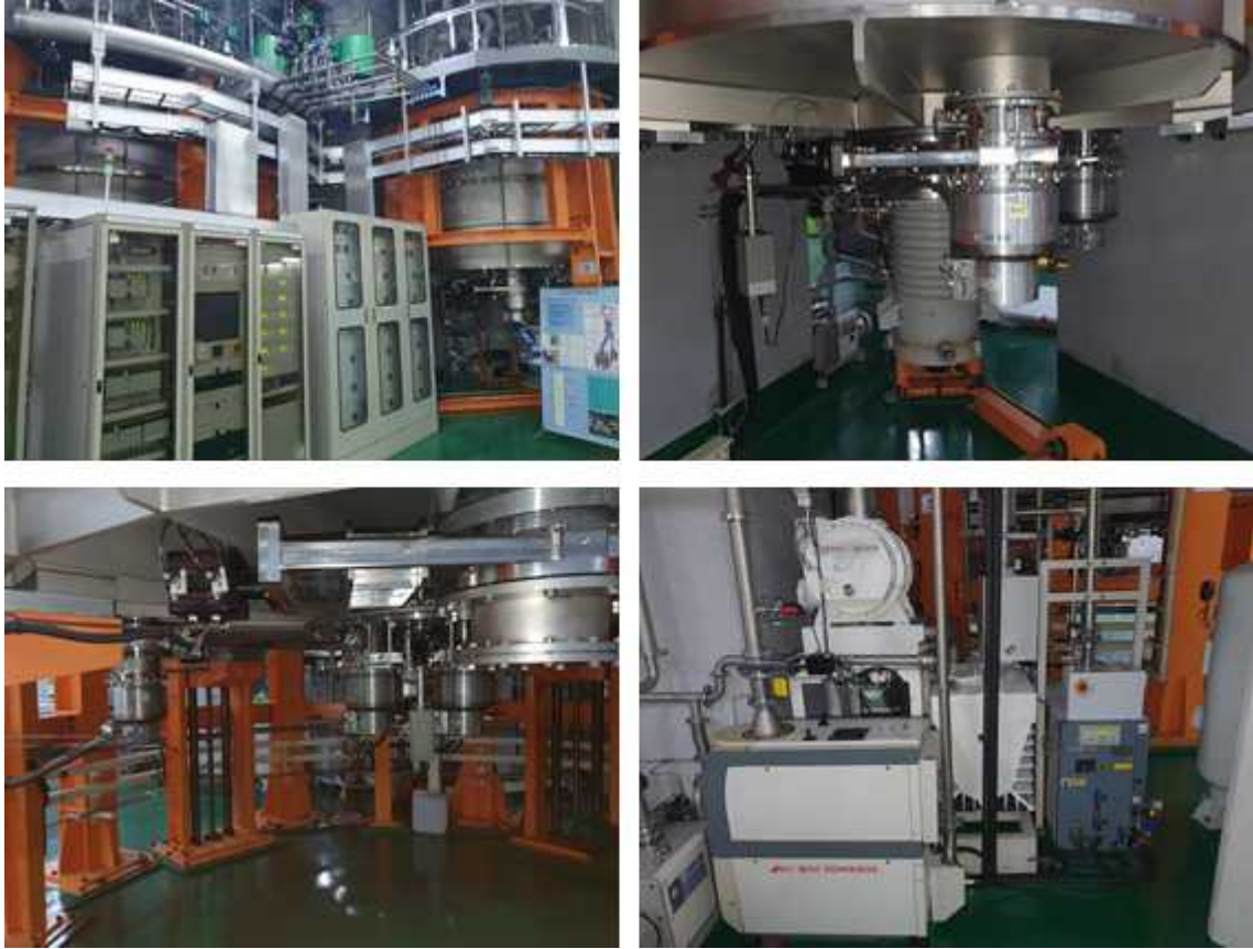
그림 5 CLS 진공배기시스템 설치 사진(좌측 상단부터 CLS 전경, CLS TMP4, 5 설치 사진, CLS TMP1, 2, 3 설치 사진, Backing 용 Dry Pump 설치 사진)
