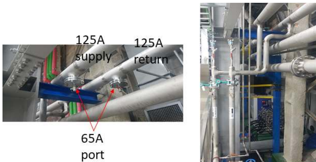
그림 3 65A Flange 포트(좌), 분기배관 설치예시(우)
