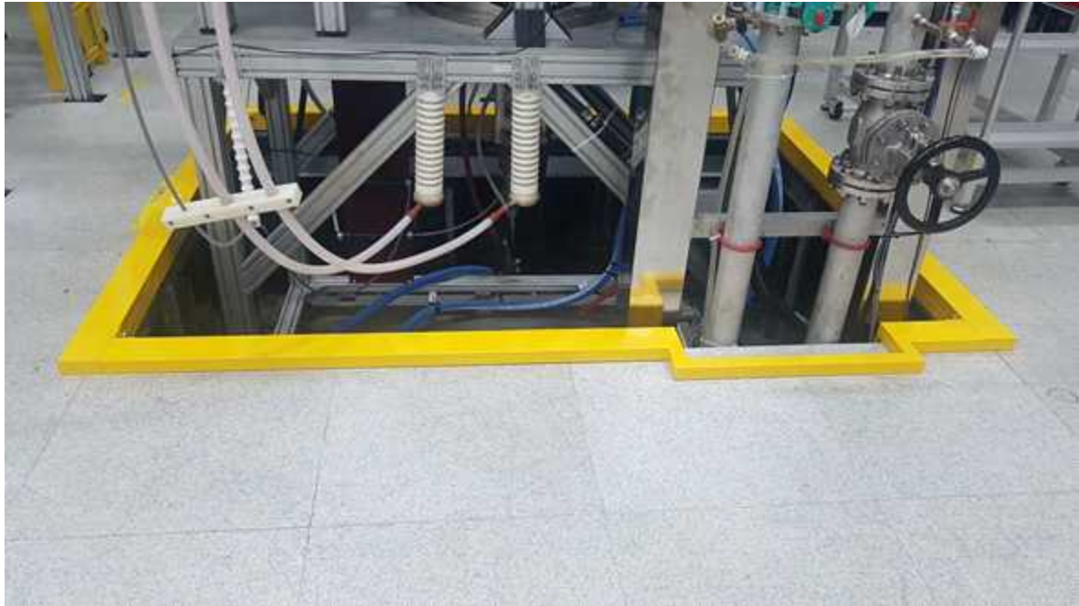
그림 14 자이로트론 경계블럭(동서남북 4면이 분리되도록 제작)
