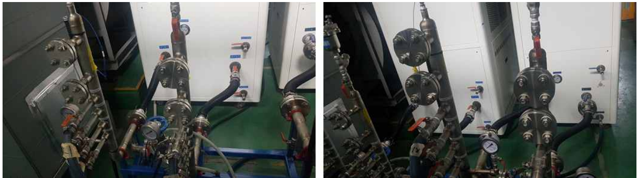
그림 4 컴프레서(좌), 윈도우(우) 칠러 배관모습. 호스를 포설하여 각 채널 하부에 연결한다.
