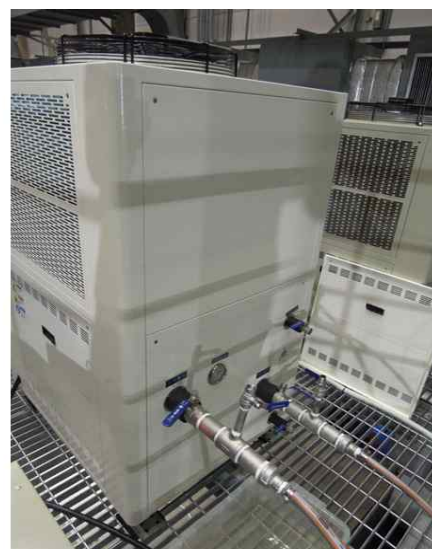
그림 14 윈도우 칠러 전, 후면 모습(후면의 배관을 4 세트로 제작한다.)
