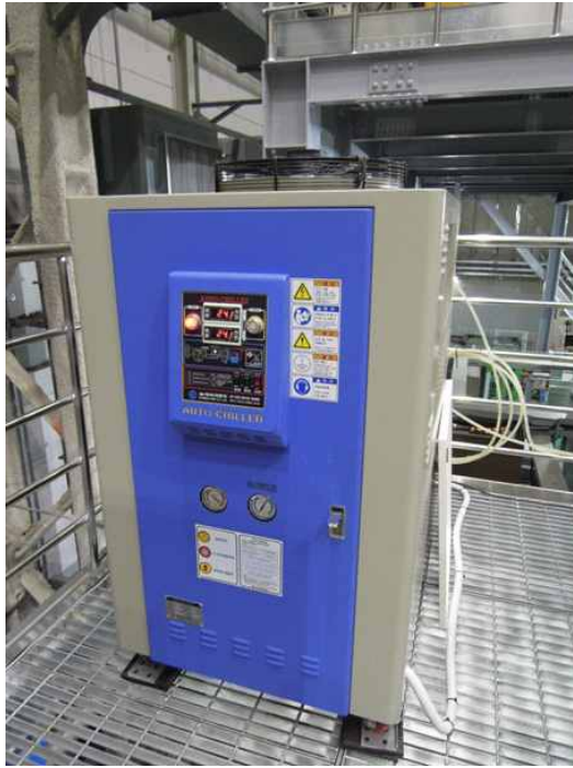
그림 16 마그넷 컴프레서 칠러 전, 후면 모습(후면의 배관을 4세트로 제작한다.)
