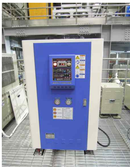
그림 14 윈도우 칠러 전, 후면 모습(후면의 배관을 4 세트로 제작한다.)
