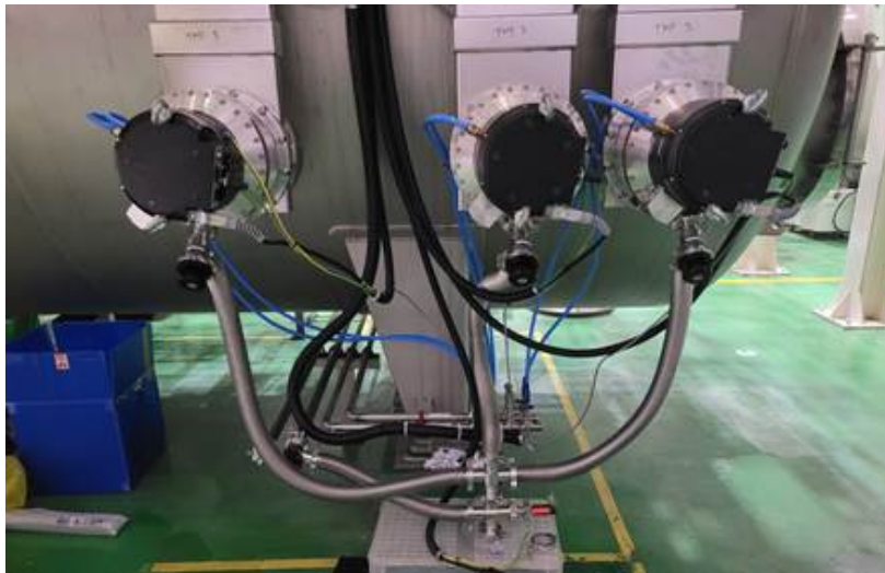
그림 13. TMP Exhaust 및 냉각수 라인 설치 형상
